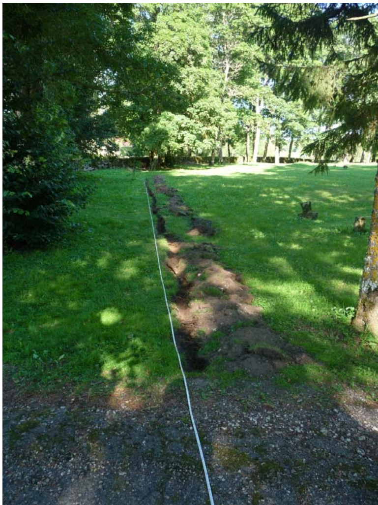
Foto 37. Kaablikraav kirikaia N-osas, vaade W-poolt, teelt.
