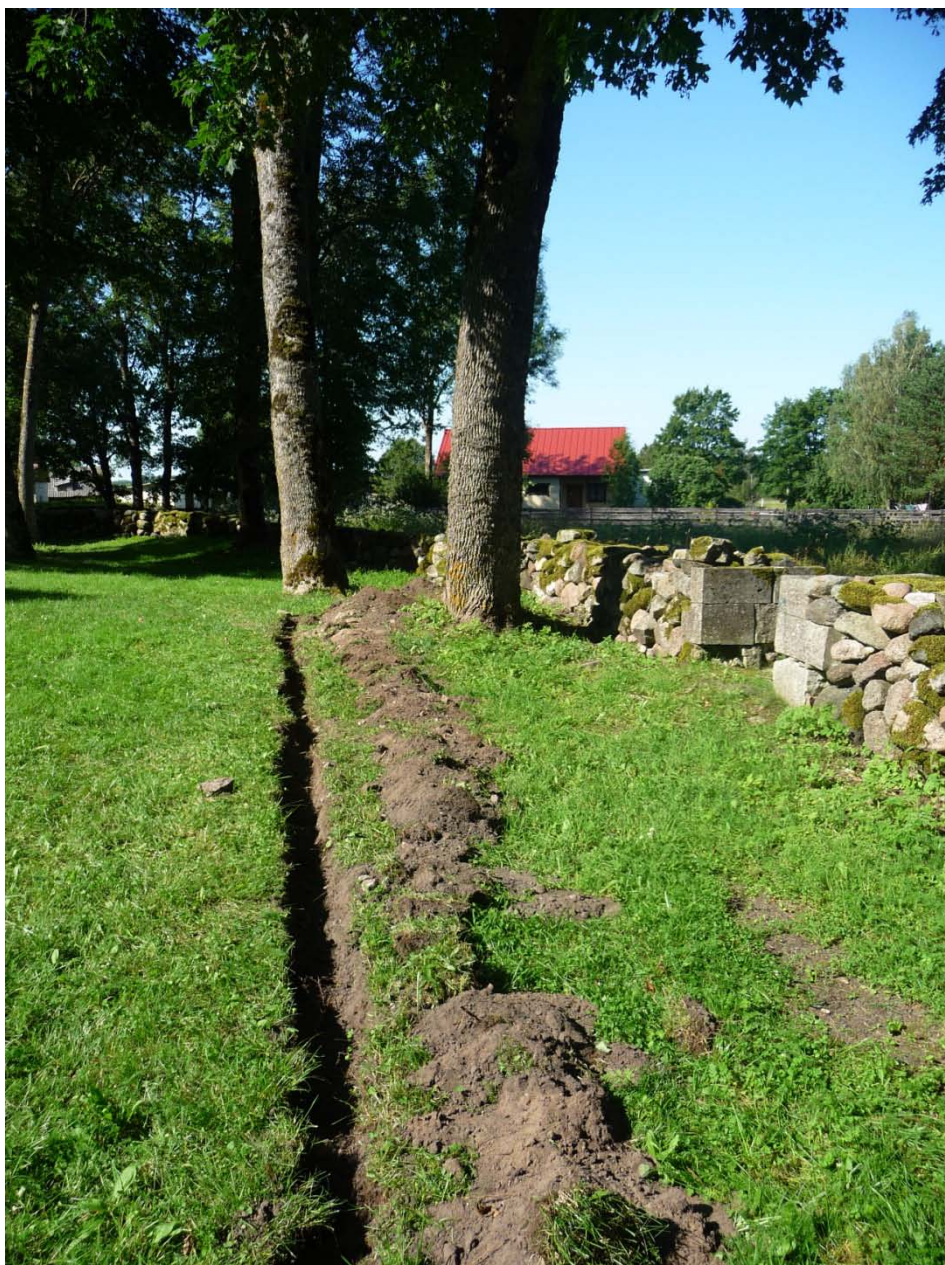
Foto 33. Kaablikraav kirikust O-pool, vaade SO-poolt.
