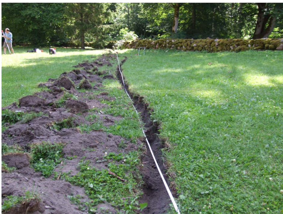
Foto 2. Kaablikraav kirikaia SO-osas, vaade W-poolt.
